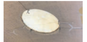
Lichtkuppel und Ventilatoren an der Decke Quelle: PTS Prototypenteile und System Technik GmbH
